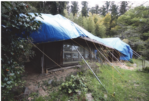
アルミサッシ戸 南西から見る
