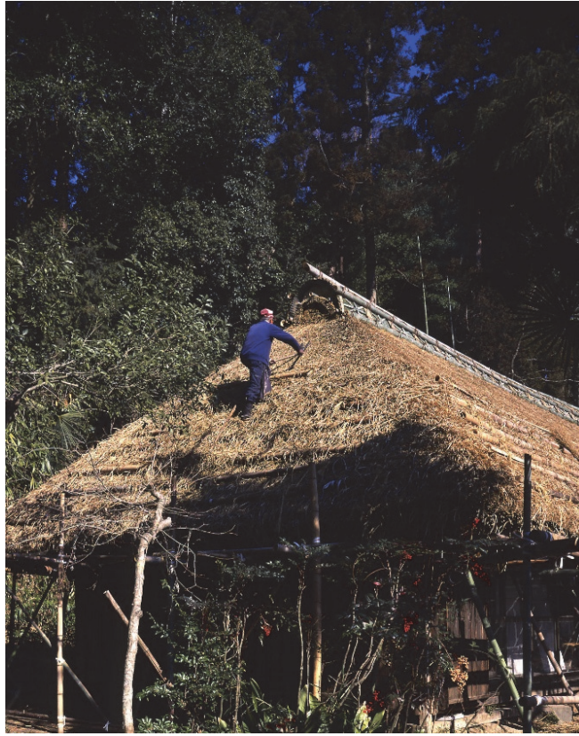
屋根葺替修理時 西から
