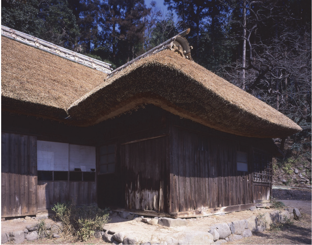
屋根葺替修理後 土間部南西から
