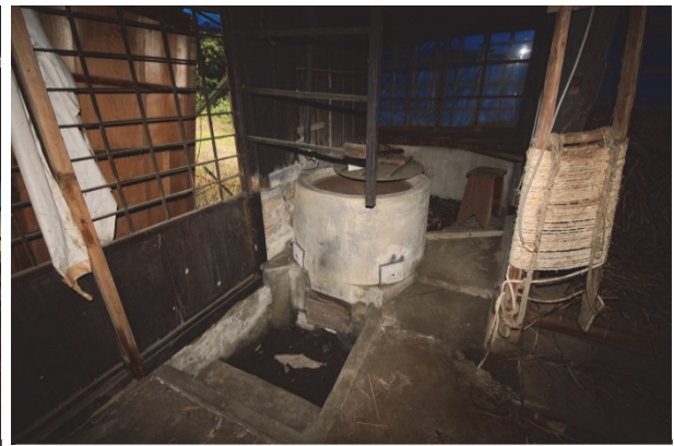
風呂北から見る
