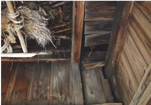
接統部 桁位置のずれ
