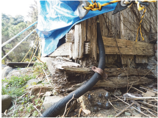
土間部南東角 土台
