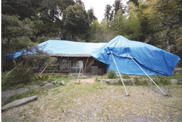
屋根 応急処置のシート
