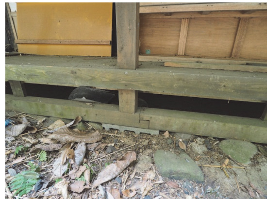
北面縁 柱と足元廻り
