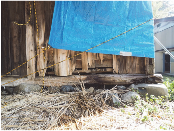
土間部南西角 土台
