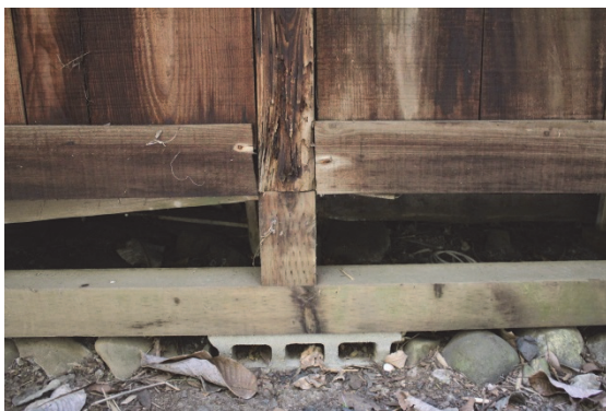
土間部棚北面 後補土台とコンクリートブロックの礎石
