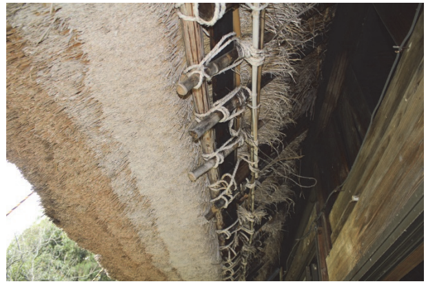
座敷部南面軒
