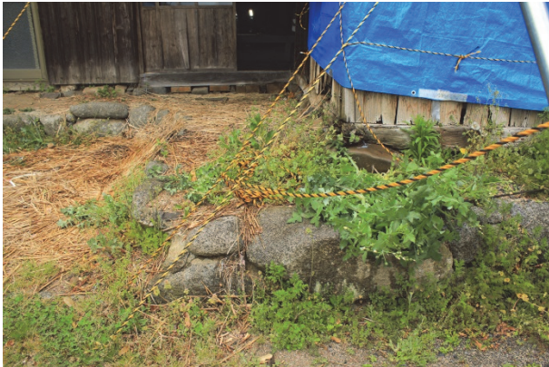
土間部 南西角石積
