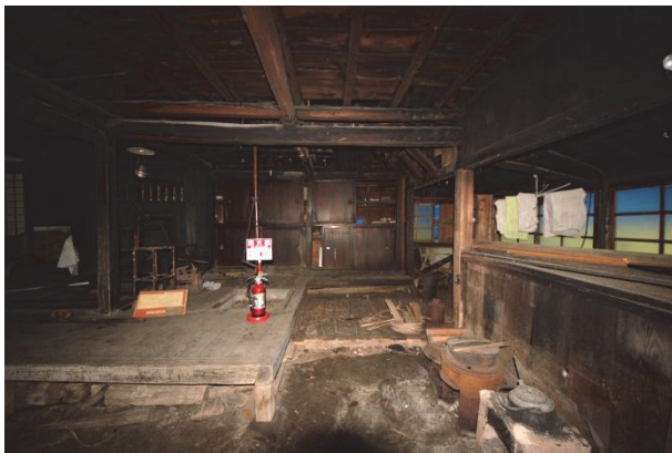
土間南から見る
