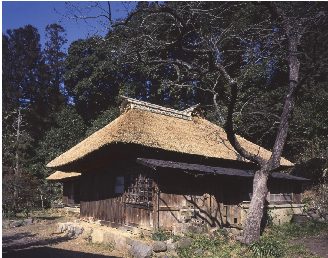
屋根葺替修理後 南東から
