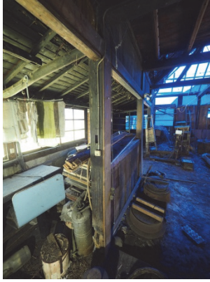
東下屋 北から見る
