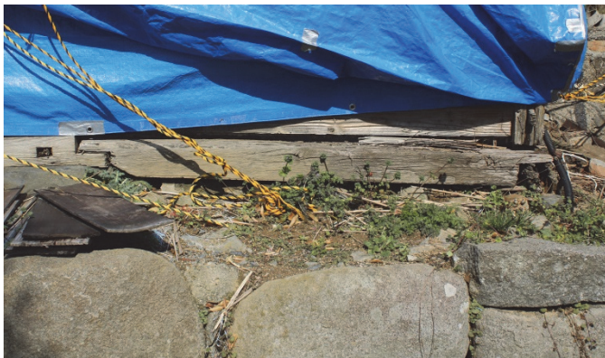
東下屋の土台（南）
