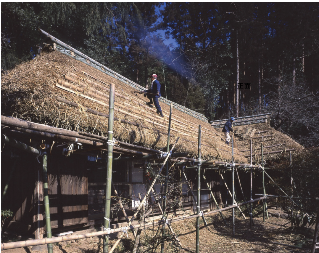
屋根葺替時 南西から
