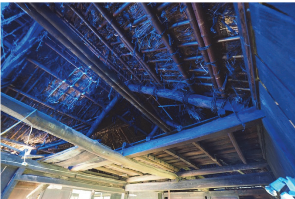
土間部小屋組 南から見る
