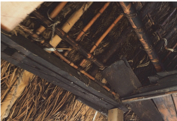
北面縁桁下 旧柱の跡と板溝
