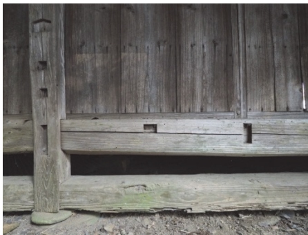
西面 高欄・床組の痕跡
