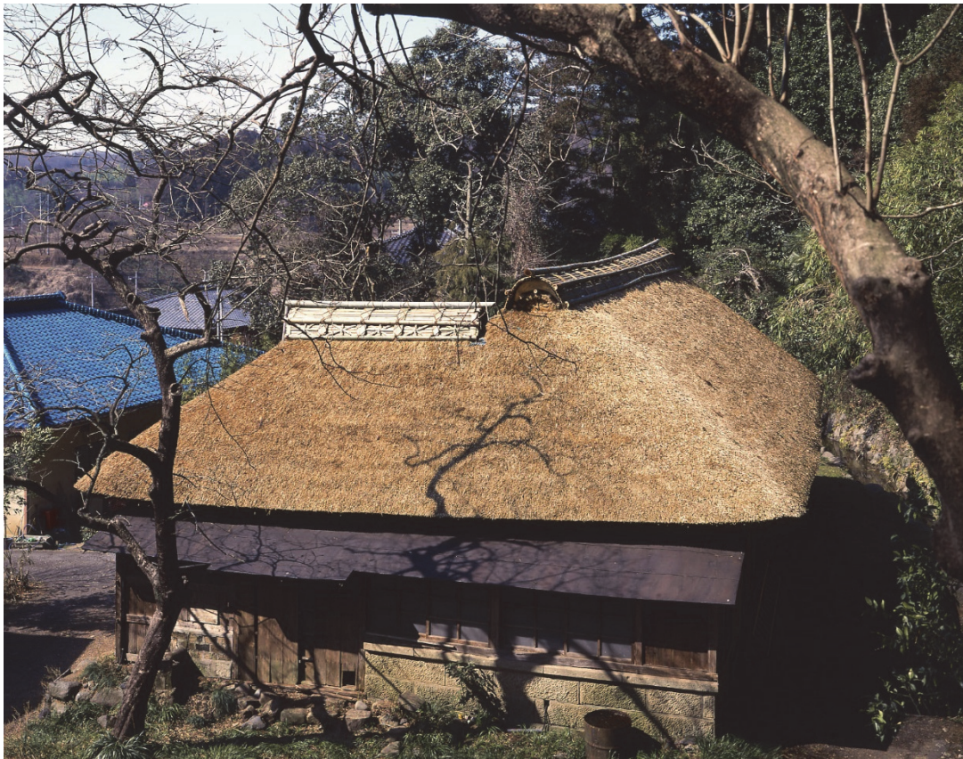
屋根葺替修理後 東上から
