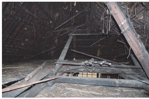
土間部小屋組 西から見る
