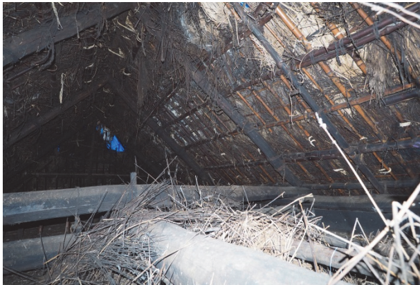
座敷部小屋組 東から見る
