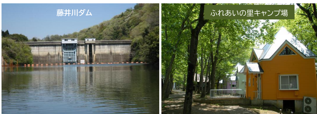
図 7-33 「ホロルの湯」周辺の施設
