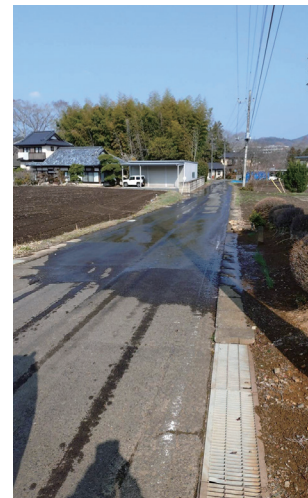
漏水現場の様子(北方地区)
