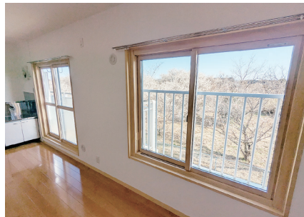
▲断熱サッシ(ペアガラス化) ※室内すべての窓に適用
