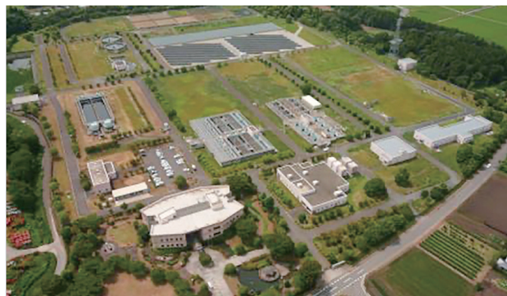
那珂市にある水戸浄水場のようす→
