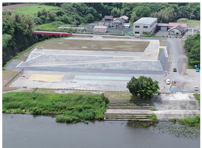
▲新・道の駅「かつら」造成工事完了後の写真
