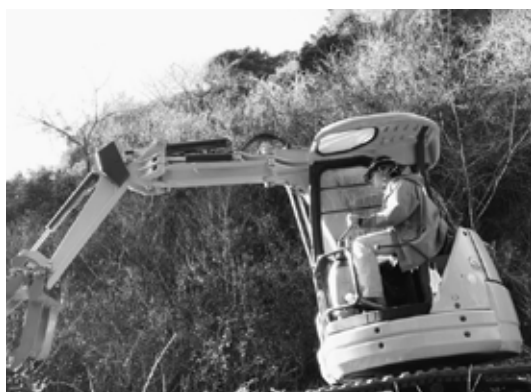
▲重機を使用し作業している様子
