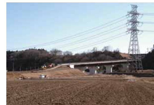
栃木県宇都宮市と水戸市を結ぶ主要道路 国道123号バイパス工事
