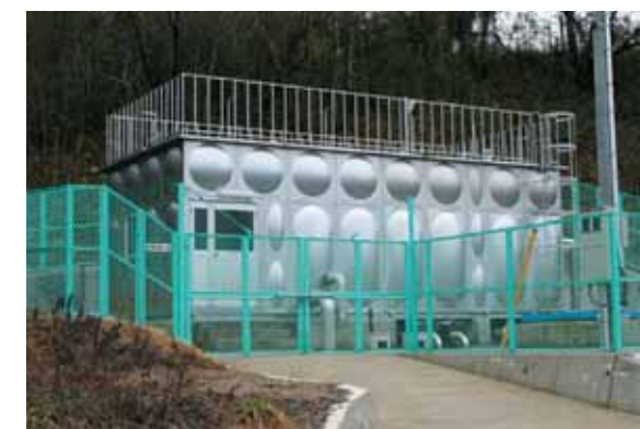
水の安定供給を図る徳蔵増圧場
