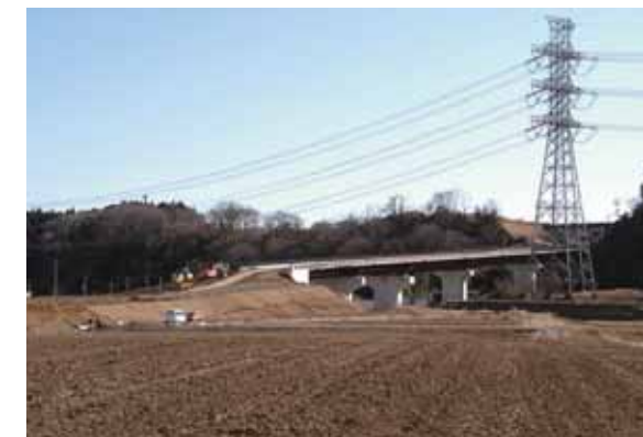
栃木県宇都宮市と水戸市を結ぶ主要道路 国道123号バイパス工事
