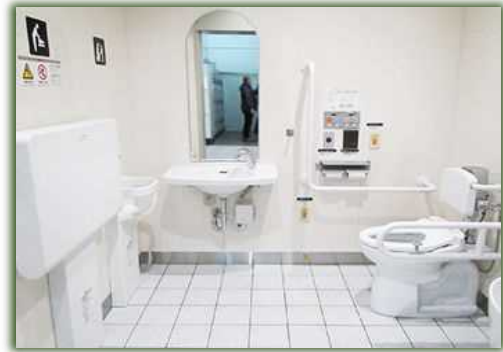
多目的トイレ
