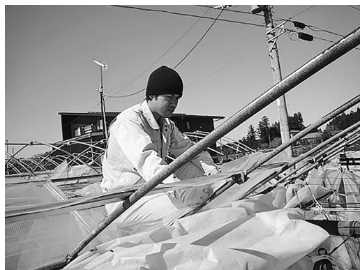
▲パイプハウスの修繕
