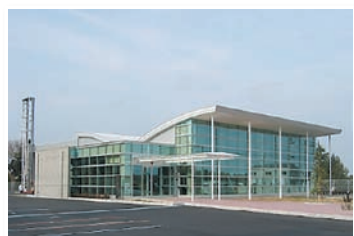
▲水戸市消防本部北消防署 城里出張所
