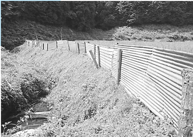
▲ 防護柵はイノシシが侵入しないように、すき間なく設置しましょう。また、イノシシが隠れやすいヤブを作らないよう心がけましょう。
