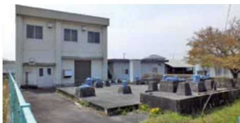
老朽化した石塚浄水場
