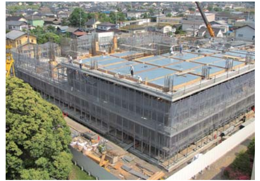
「本庁舎建設工事の状況」
