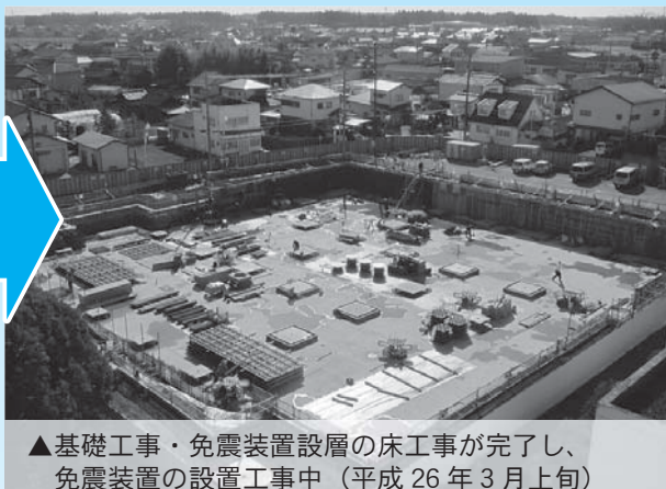
▲基礎・地中梁の配筋、コンクリート打設工事中 (平成 26 年 1 月末)
