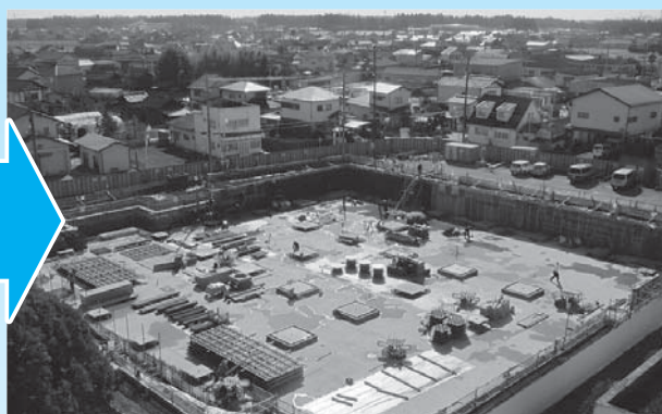
▲基礎工事・免震装置設層の床工事が完了し、 免震装置の設置工事中 (平成 26 年 3 月上旬)
