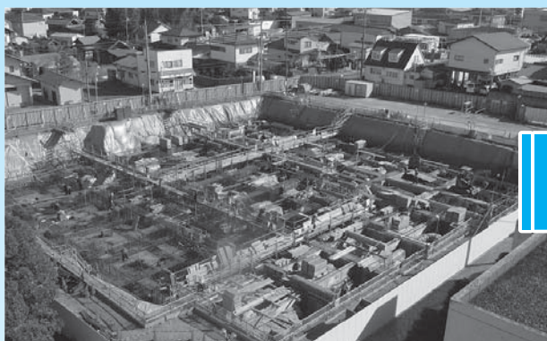
▲基礎・地中梁の配筋、コンクリート打設工事中 (平成 26 年 1 月末)
