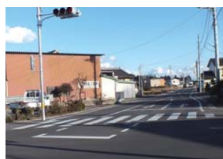
「拡幅改良した石塚地内の町道」
