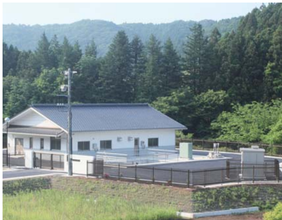
「完成した古内地区農業集落排水処理施設」
