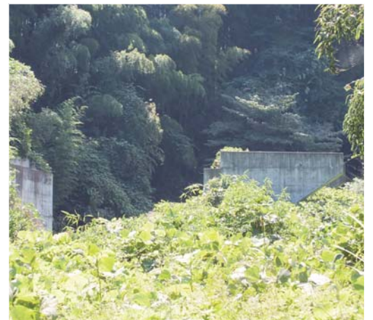
「既にできている橋台」
