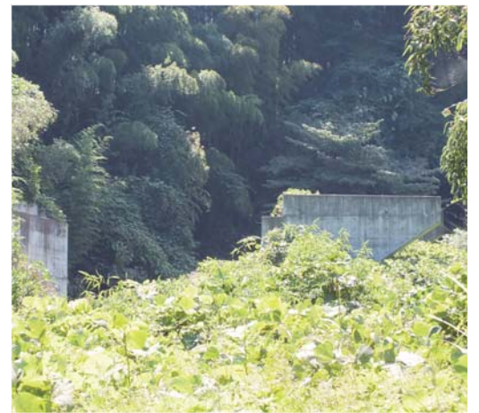
「既にできている橋台」
