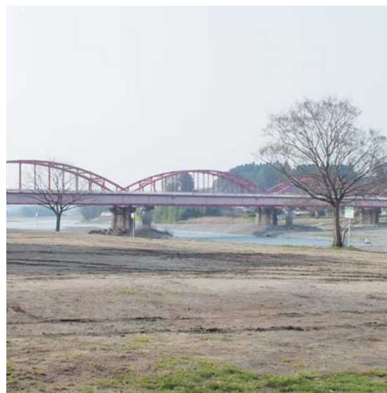
那珂川大橋周辺
