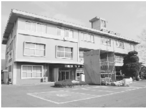
▲解体前の本庁舎
