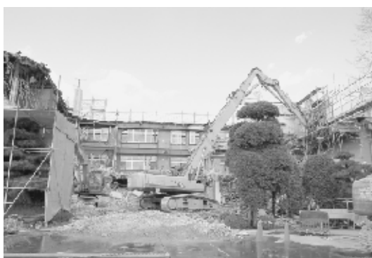
▲解体作業の様子
