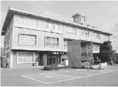
▲解体前の本庁舎
