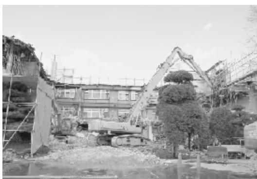
▲解体作業の様子
