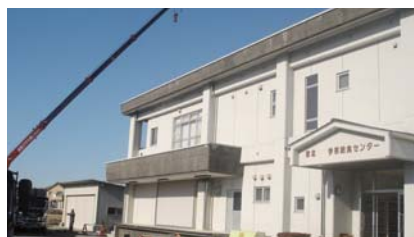
工事中の常北給食センター
