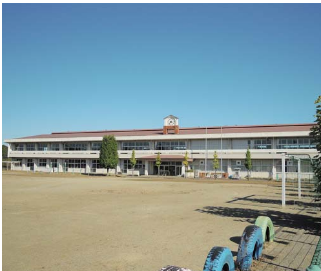
閉校となった坏小学校
