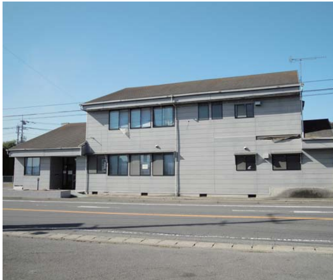
被災後の坏地区公民館
