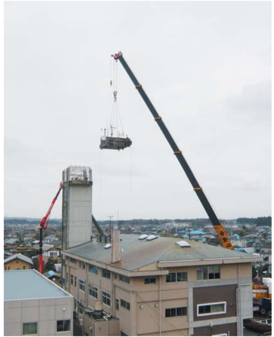
望楼の撤去作業 (550 t のクレーンを使用)
