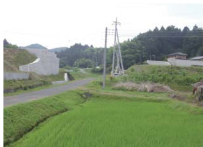
工事状況（錫高野地内）
