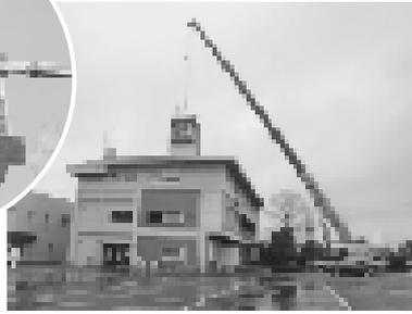
3月22日に本庁舎の望楼を切断し撤去する工事が行われました。役場駐車場及び町道、付近の民家を立ち入り禁止にし、大型クレーン3台による大がかりな工事で、望楼の天井部分とそれを支える4本の柱が切断されました。
