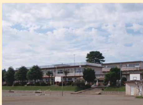
着工前の常北中学校
