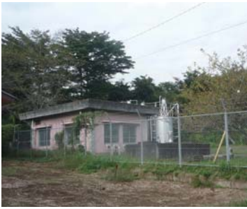
老朽化した赤沢浄水場
