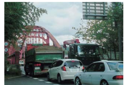
現在の那珂川大橋
