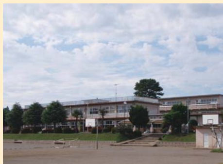
着工前の常北中学校
