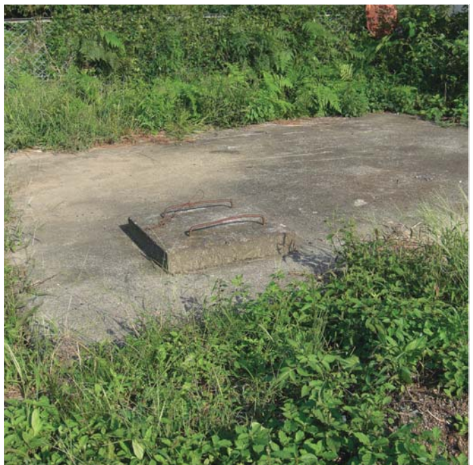
桂地区にある防火水槽
