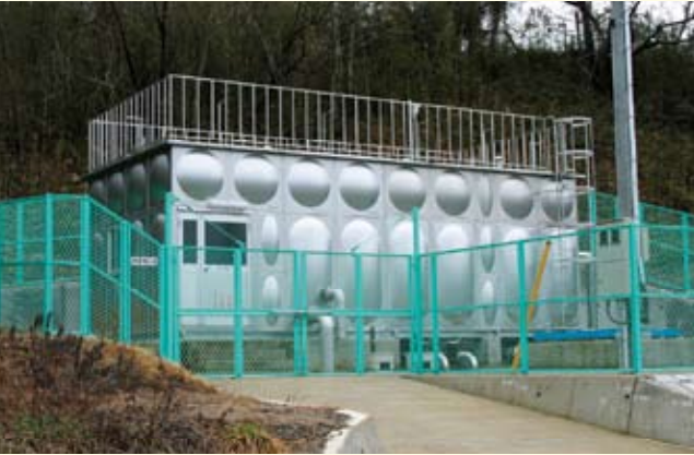
水の安定供給を図る徳蔵増圧場
