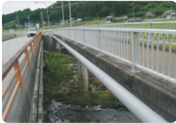
送水管の橋梁添架工事
