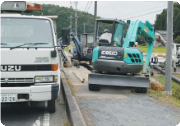
送水管埋設工事（大字小勝地内）
