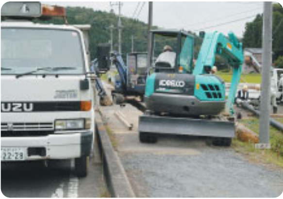
送水管埋設工事（大字小勝地内）
