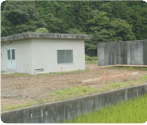
改修予定の上古内送水場
