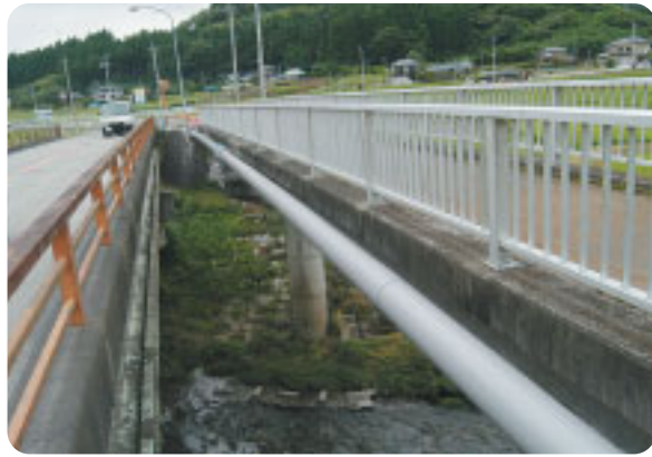
送水管の橋梁添架工事
