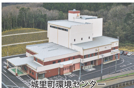
城里町環境センター
