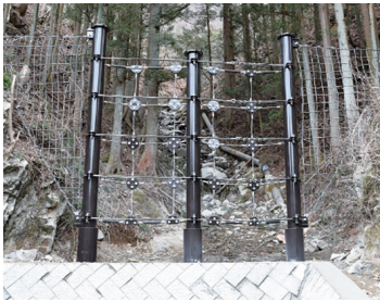
アーバンガード工法
