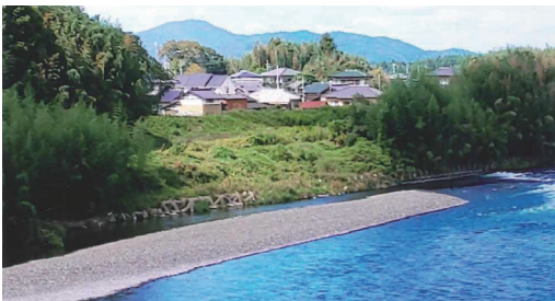
千代橋上流左岸
