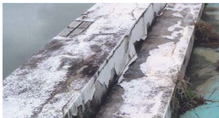
石塚小学校プール
