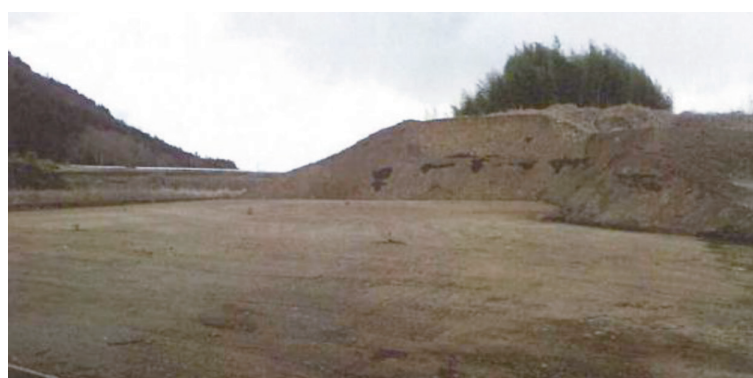
白山グラウンド脇 土砂ストックヤード
