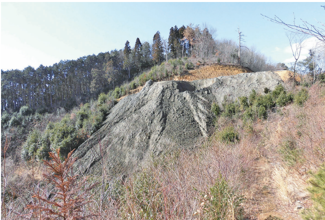
大網地区に投棄された不法残土
