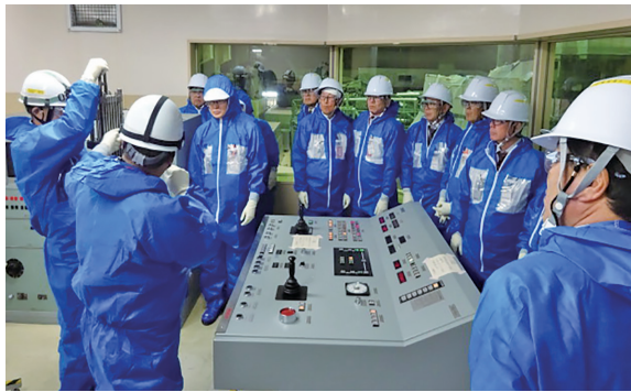
原子炉建屋内で説明を受ける
