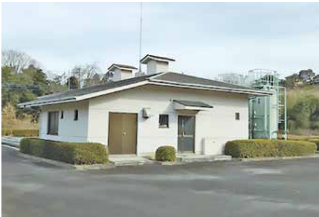
上入野農業集落排水施設
