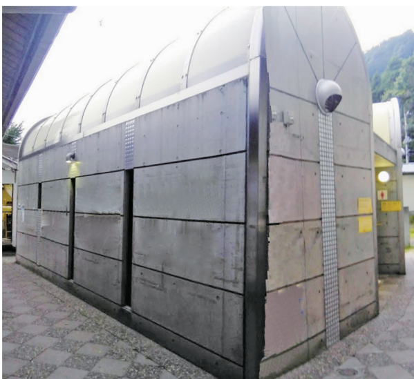
現在の道の駅かつらトイレ
