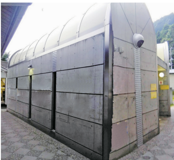
現在の道の駅かつらトイレ
