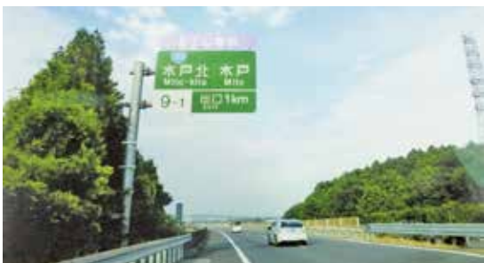
水戸北インター出口標識
