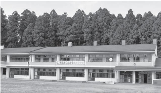
▲県の埋蔵文化財センターとして利用されることになった旧北方小学校の校舎
