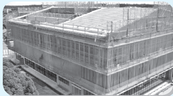
▲9月中旬 上棟（屋根部分のコンクリート打設）
