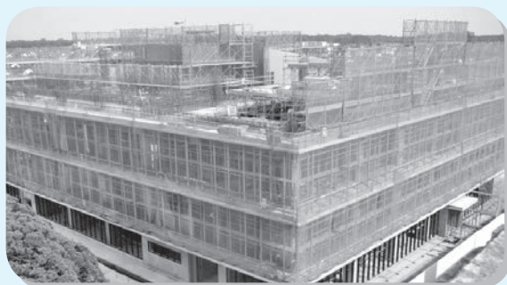
▲8月上旬 屋上階床・立上り配筋
