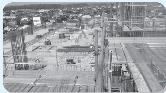
▲8月上旬 屋上立上り配筋工事
