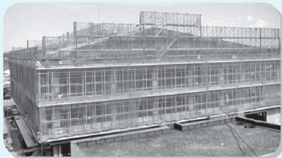
▲9月上旬 屋根部の配筋工事
