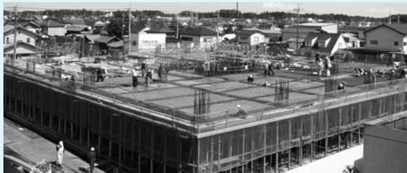
▲ 5月上旬 2階床配筋工事
