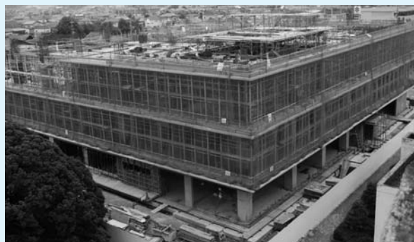
▲▼ 7月上旬 3階立上り 柱・梁等の工事中
