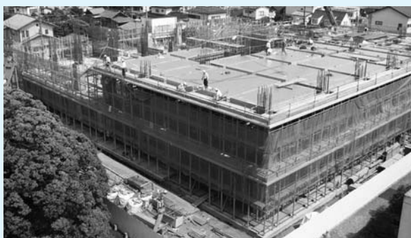
▲ 6月上旬 3階床工事
