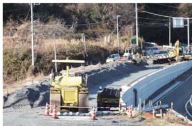
旧茨鉄軌道敷 (境橋)
