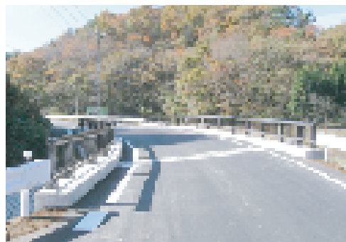
完成した新滝の沢橋
