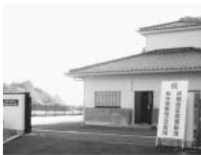
農業集落排水処理施設（孫根地区）
