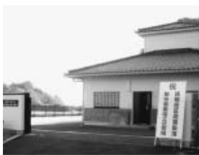
農業集落排水処理施設（孫根地区）
