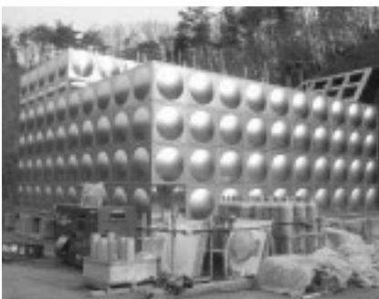
水道未普及地域解消事業 小勝配水場配水池工事の様子
